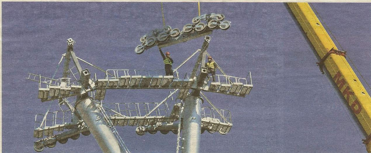
Arbeiter setzten die erste Radbatterie für den Seilzug in den Stützpfiler der Seilbahn nahe des künftigen Eingangs zu den Gärten der Welt am Blumberger Damm ein. Foto: hari
