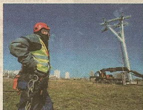
Die erste Stütze der Seilbahn wird montiert DPA/CARSTENSEN
